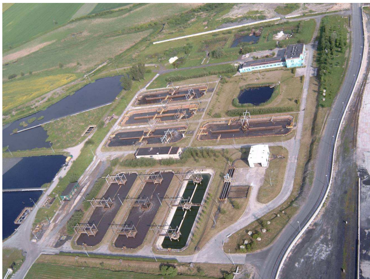
Fot. Oczyszczalnia ścieków przy zakładach Nordzucker S.A. w Chełmży.
