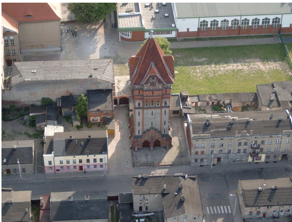
Fot. Wieża ciśnień.
