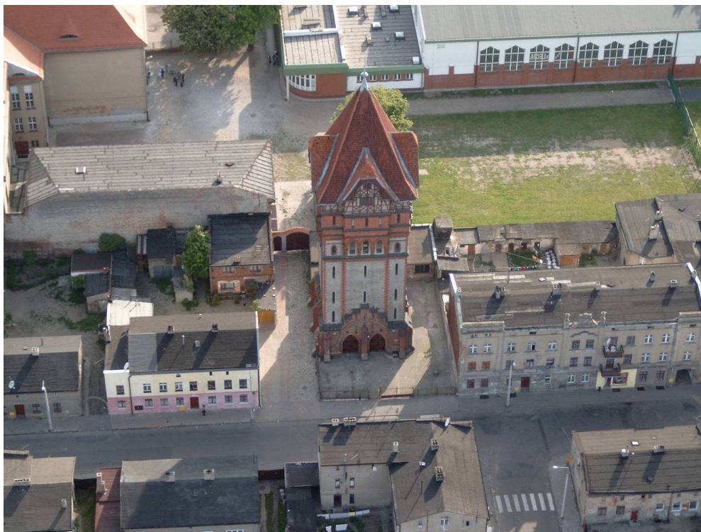
Fot. Wieża ciśnień.
